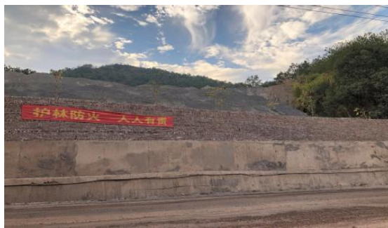
照片 8 治理后挡土墙
